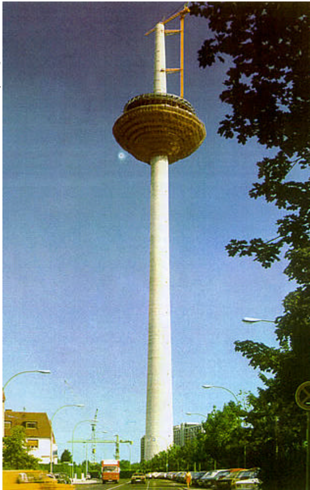
Turmschaft bei 310m Pumphöhe
